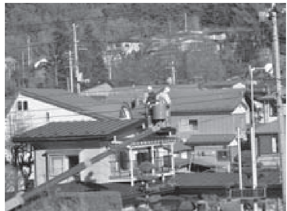
光ケーブル工事の様子
