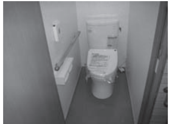
水洗化工事を行ったトイレ
