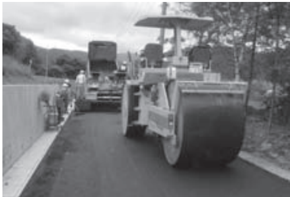
町道舗装工事の様子
