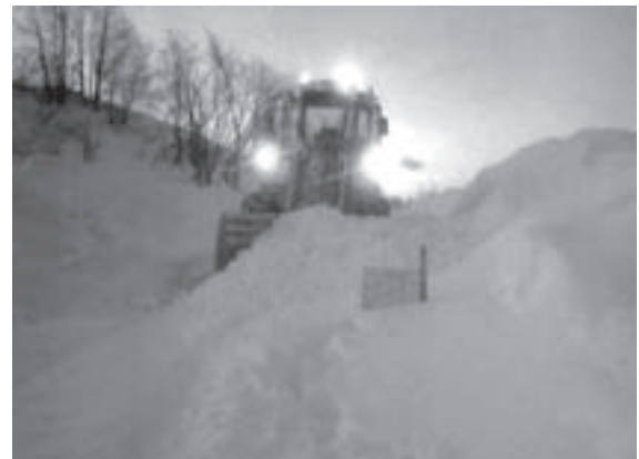
町道の除雪作業風景
