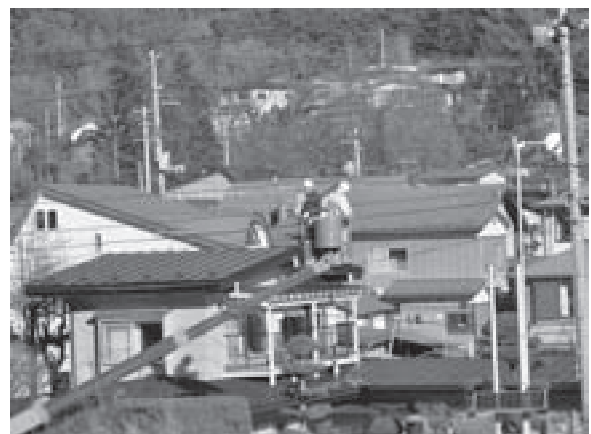
光ケーブル工事の様子
