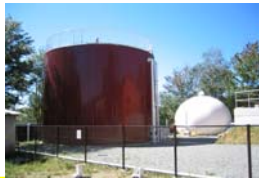
H15 バイオガスシステム 37kW/葛巻町⑩ H13 葛巻バイオガス高度利用コジェネレーション システム研究会・燃料電池 1kW ／(社)葛巻町畜産開発公社⑩
