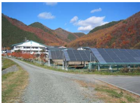
◆写真：葛巻中学校太陽光発電システム50kW
