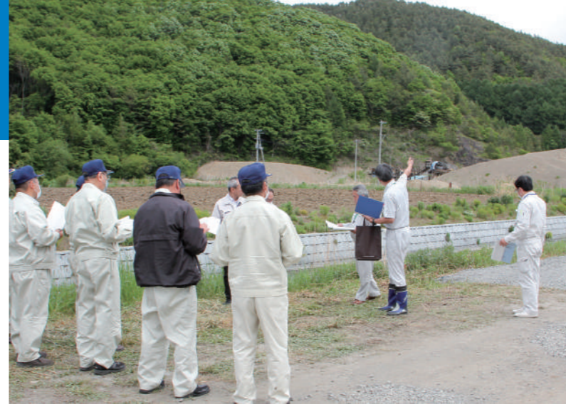
馬淵川栗山橋下河川復旧工事
