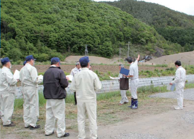
馬淵川栗山橋下河川復旧工事
