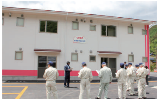
新たに建てられた若者定住促進住宅＝田子地区
