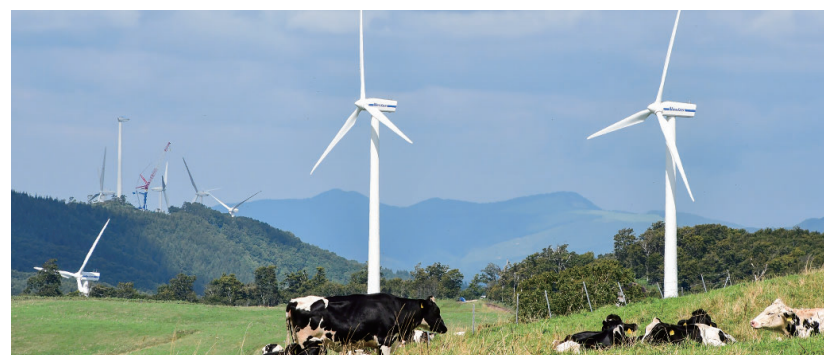
建設が進められている上外川風力発電所【9月15日撮影】
