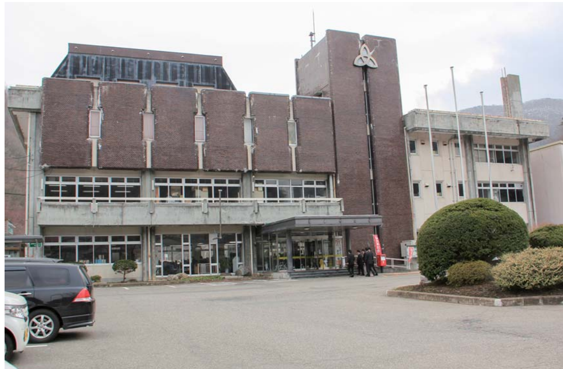
老朽化が進む現庁舎。
