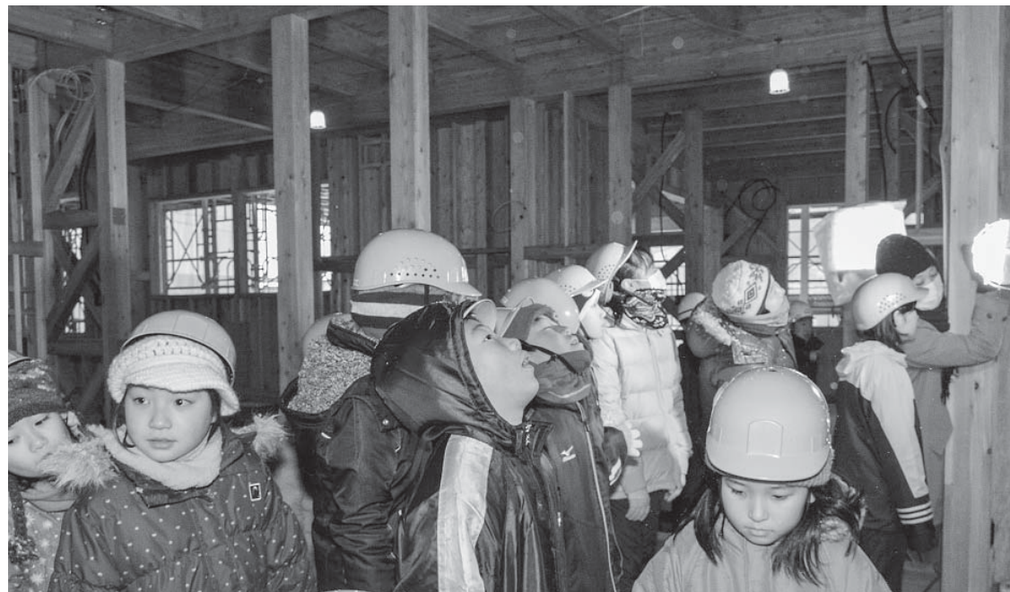
建設中の江刈小学校校舎を見学する児童。議会では、25年9月に提出された江刈小学校改築の要望書を審査した結果、改築は妥当と認めています。
