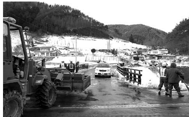
厳しい経済状況の中、完成した佐ノ渡橋
