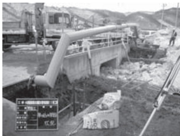
水道管の設置工事の様子
