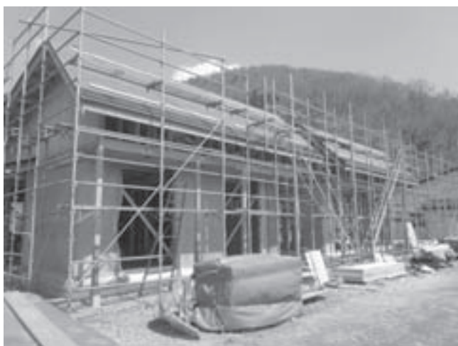
定住促進住宅の建築を進めています
