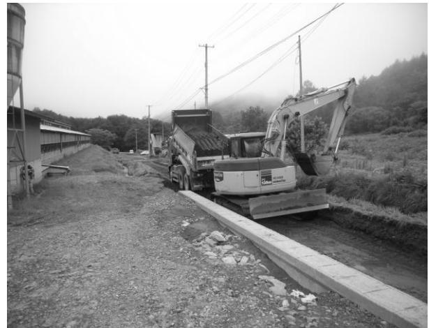
町道の修繕工事の様子
